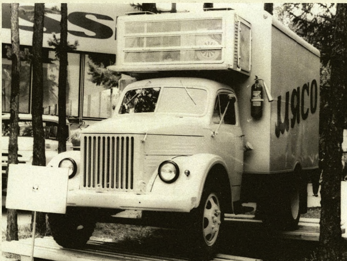
ЧАР-12 на шасси ГАЗ-51А 1967–1970 гг., оборудованный для транспортировки мясных неразделанных туш
