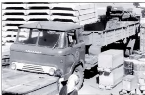
▲ Автомобиль переходного выпуска. Дополнительные фары уже отсутствуют, но в задних стойках кабины еще стоят панорамные стекла. Фото Л. Сулавичюса
