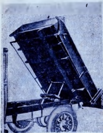
Фиг. 51. Цилиндры давления и штоки самосвала „Автокар“ в момент под'ема платформы.
