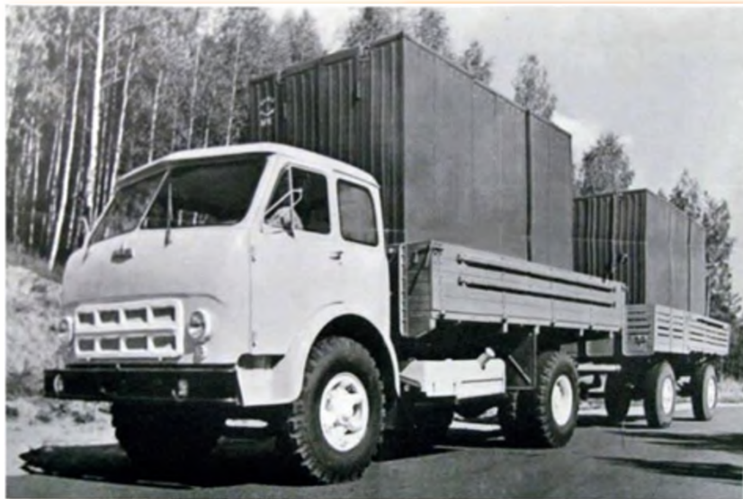
Двухосные МАЗ-500 дане с прицепом не достигали до разрешенной в Европе полной массы магистральных автопоездов
