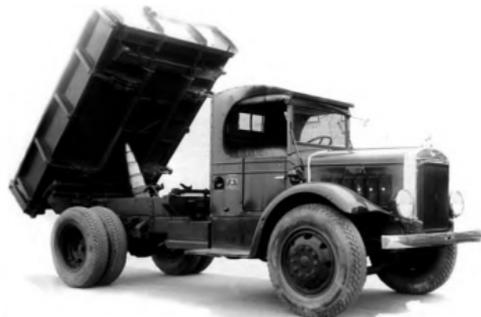
Американский 5-тонный самосвал «МАН» с гидравлическим подъемником, разработанным в НАТИ в 1935–1940 годах.
