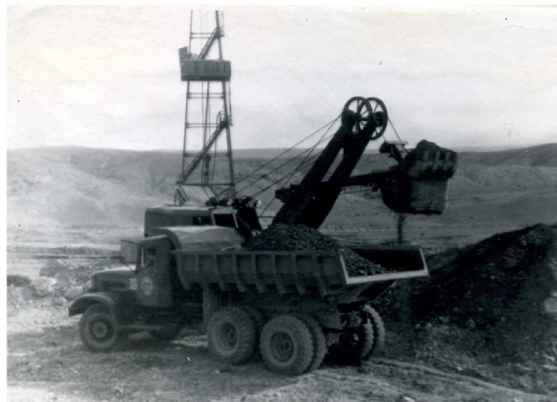
Погрузка щебня экскаватором «Ковровец» в забое
