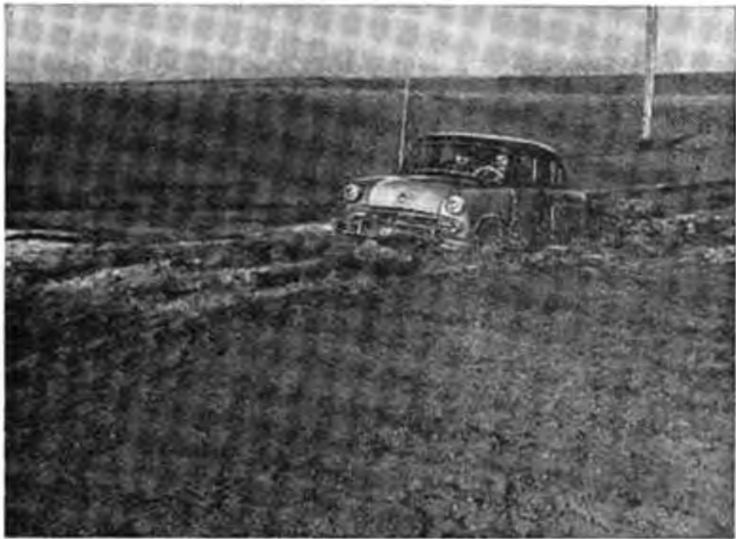
Рис. 4. Движение автомобиля по размытому участку дороги с глубокой колеёй
