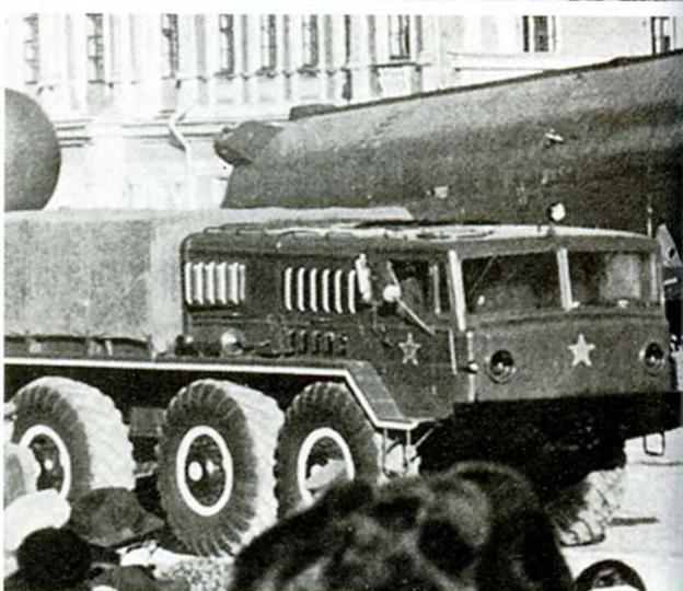
*Серьезным образом доработанный тягач Маз-535 использовался в качестве носителя беспилотных самолетов-разведчиков Ту-123 (ДБР-1) «Ястреб».*
