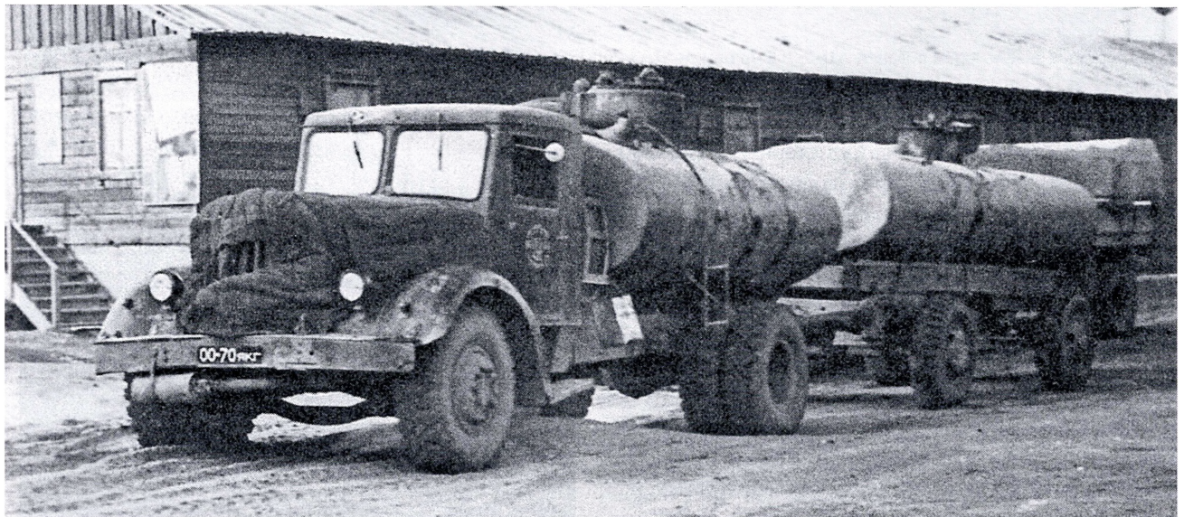
Автопоезд автопредприятия г. Ленска в составе поздней АЦ-8-200 на шасси позднего МАЗ-200, № 00-70 якг, и самодельного прицепа-цистерны на «МАЗовском» ходу. Задние крылья у машины отсутствуют. Якутская АССР, 1970-е гг.
