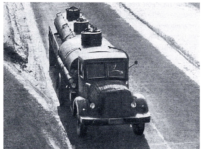
Усиленный вариант столичного автопоезда в составе поздней АЦ-8-200 на шасси «носатого» МАЗ-200 с дизелем ЯАЗ-206А и 8-тонного прицепа-цистерны. Москва, МКАД у пересечения с Рязанским шоссе, февраль 1966 г.
