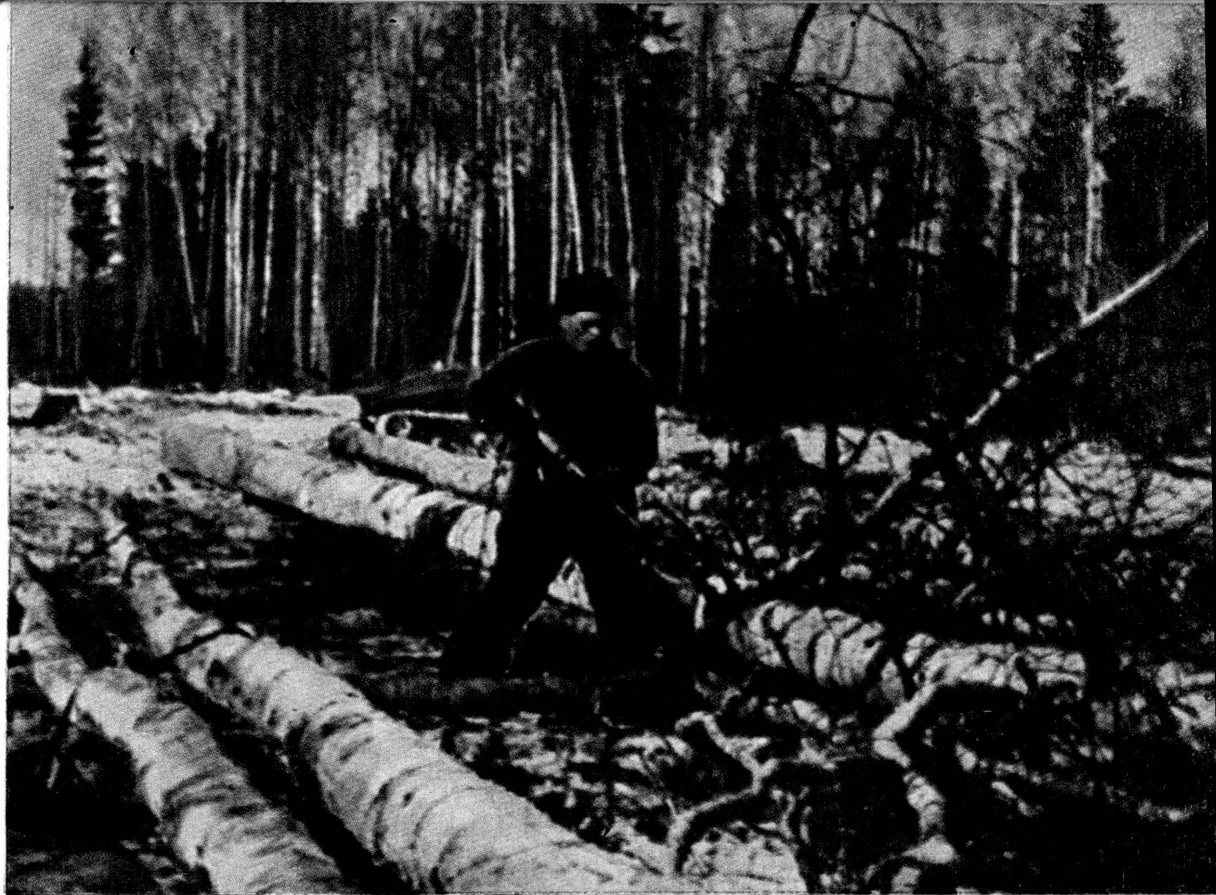
Механизированная обрезка сучьев
