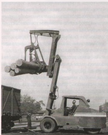
Погрузчик 4001 с грейферным захватом для сортимента на железнодорожной станции
