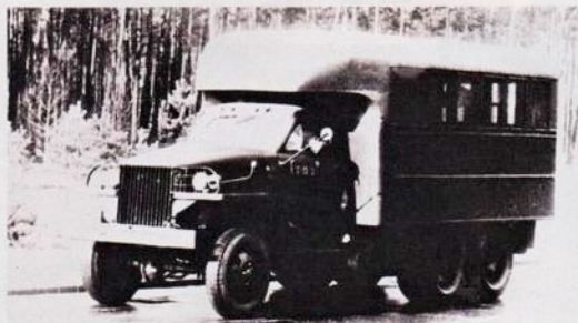
Пассажирский кузов-фургон на шасси Studebaker US6. Предположительное наименование «Прогресс-2»
