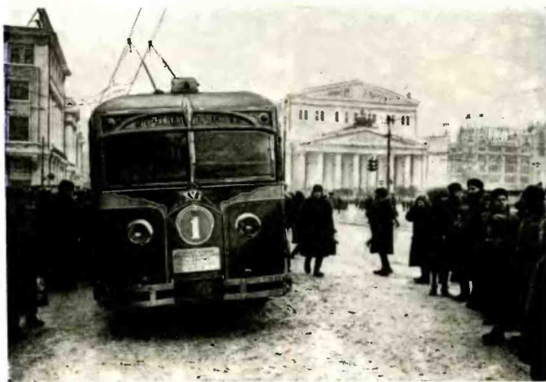
Опытный образец 3-осного ЛК-3 (длина — 12 м, ширина — 2,3 м, число мест — 85). На лобовой стороне знаменательная надпись «Подарок XVII съезду ВКП(б)».
