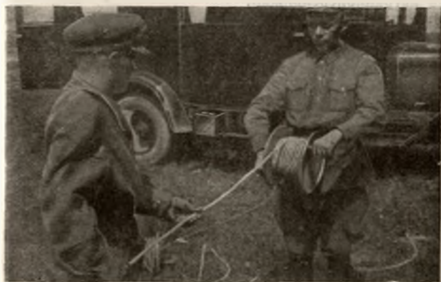
Рис. 15. Правильная вмотка кабеля
